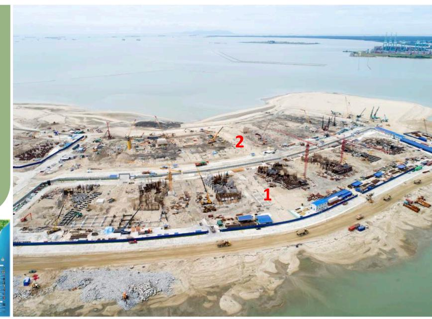
海悦湾3:正负零完成,开始上部结构施工; 海悦湾4:承台施工当中。
